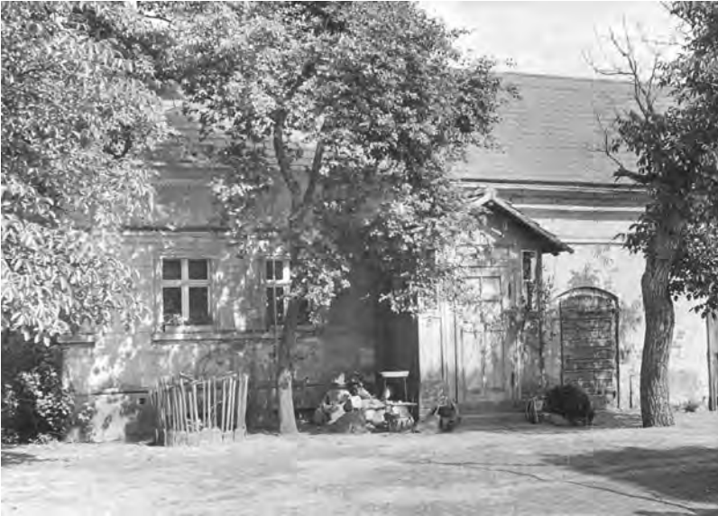
Abb. 11: Die „nowa Rychownja“, die Haus-Nr. 153, 1955. (Foto: Kurt Heine, Sorbisches Kulturarchiv Bautzen)
